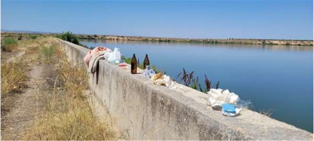
Foto 15: vertidos de basuras en zona vedadas a la pesca en el embalse de Castrejón.
